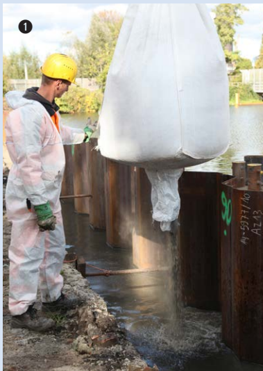
Sanierung Rummelsburger Bucht, Berlin 1 Vorher: Herstellung einer vertikalen Tonsperre zur Abdichtung und Hinterfüllung der Spundwand als Teil der Altlastensanierung. 2 Nachher: Hochwertige Wohnbebauung am Rummelsburger See im Stadtteil Friedrichshagen-Kreuzberg von Berlin.
